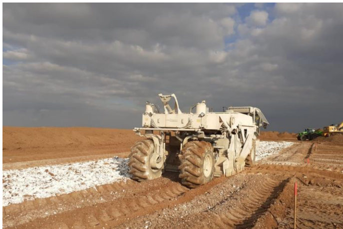
Traitement des sols. Source SCSNE Secteur 4
